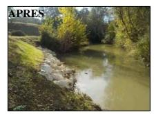
L'entrée du bras de coupure est bouchée par la construction d'un ouvrage en terre, qui reproduit une berge naturelle. Ainsi la circulation de l'eau est forcée dans le méandre.
